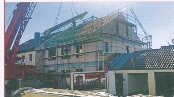
**Maßarbeit** lieferte der Montagetrupp von Talbau-Haus ab. Er hievte die vorgefertigten Wand- und Dach-elemente in das zuvor aufgestellte Gerüst hinein, um sie dort auf dem bestehenden Keller zu einem Haus mit drei Etagen zu addieren. Links und rechts wurde das neue Gebäude fachgerecht an die alte Haushälfte und die bestehende Garage ange-dockt, die zum Schluss die passende Optik erhielt.
